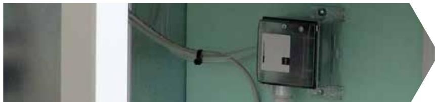
Sensori di pressione per il controllo della portata o della pressione
